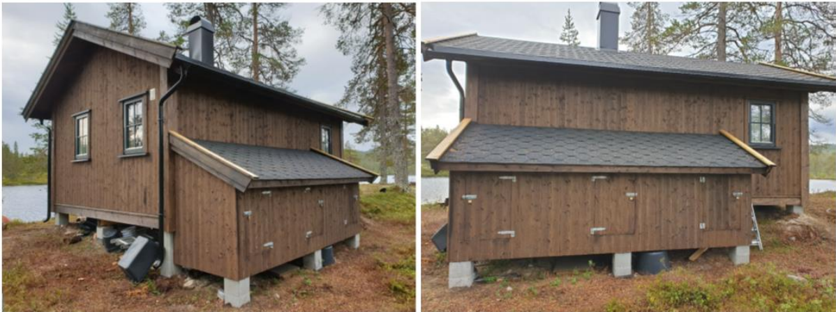
Foto fra SNO-rapport som viser ikke omsøkt tilbygg (1,20 m x 4,50 m).
