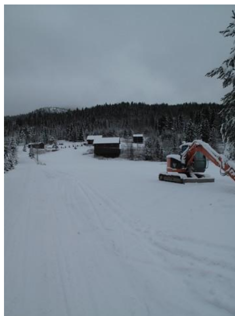
Ikke et helt godt bilde, men parkeringen er der hvor graveren står!
